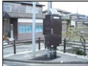
マンホールポンプ制御盤 監視システム (太陽光発電付)
